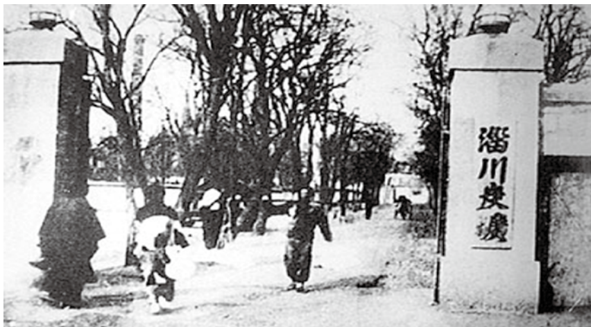
当年德华矿务公司淄川炭矿大门
