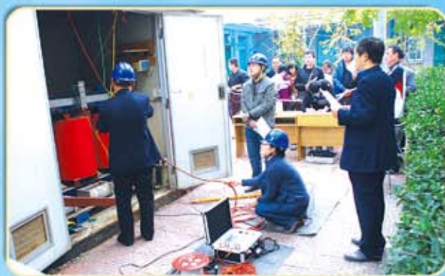
变压器的极性接线组别变压比测量
