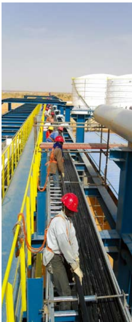
充分利用当地雇员进行电力敷设，安全措施到位
