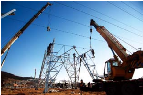
趁着气温略有回升，济南供电公司集中优势力量，确保工程早日竣工。图为1月4日，220千伏兴姚、姚文线线路改造工程施工现场，施工人员在两辆吊车的帮助下组建角钢塔，仅用1天时间，就顺利完成了组塔任务。
