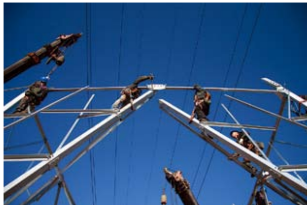
1月4日，220千伏兴姚、姚文线线路改造工程施工现场，施工人员身着全方位安全带，按照施工图纸要求依次组建角钢塔。
