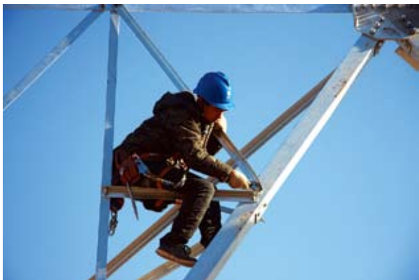
1月4日，220千伏兴姚、姚文线线路改造工程施工现场，施工人员在组建的新塔上依次较紧螺丝，不放过每个缺陷，确保施工质量。
