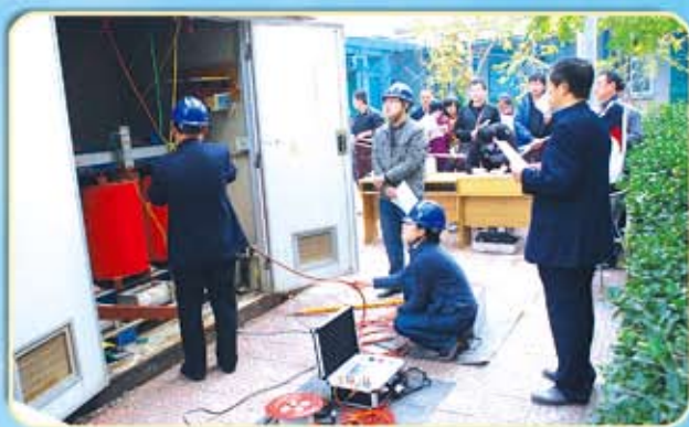
变压器的极性接线组别变压比测量
