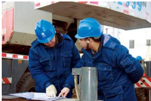
1月4日，220千伏兴姚、姚文线线路改造工程施工现场，施工人员正在按照图纸讨论塔材吊装、安全措施布控等具体施工细节。
