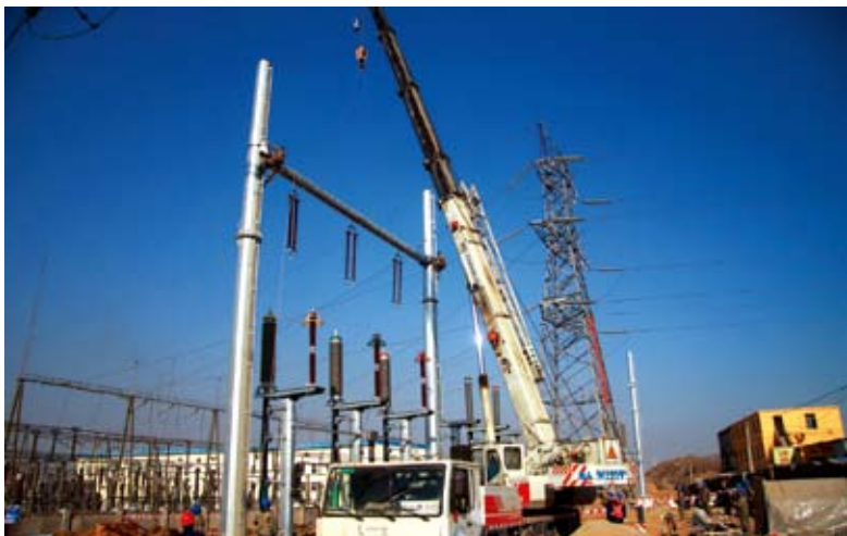
元旦刚过，济南供电公司迎来了2014年第一个220千伏停电项目：220千伏兴姚、姚文线线路改造工程。图为1月4日，施工人员在220千伏姚家变电站外架设门型架。
